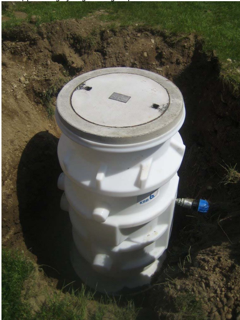
slika 1, primer vgrajenega hišnega črpališča
